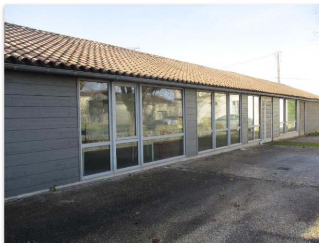
Le Préau (à côté de la bibliothèque)
